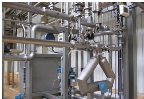
作者: 车轲 单位: 黑龙江杜尔伯特伊力乳业 品牌: Emerson-艾默生 型号: CHF-100H密度/质量流量计 应用领域: 食品饮料加工 采购/使用年份: 2003年 应用单位: 黑龙江杜尔伯特伊力乳业 控制用途: 应用于奶油的分离和标准化控制 在用数量: 1 上传时间: 2007-10-26
