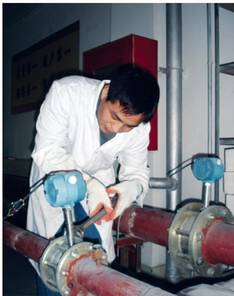
左右，到达现场后，发现系统零点输出电流约为8mA。由于现场系统接地情况不良，人能感觉到麻电现象，改用单独的24V直流电源供电后，流量计零点显示为4.01mA，后微调了一下，系统启动后，输出电流增加到6mA左右（不接PLC系统），跟实际流量相符故判断流量计工作正常。
