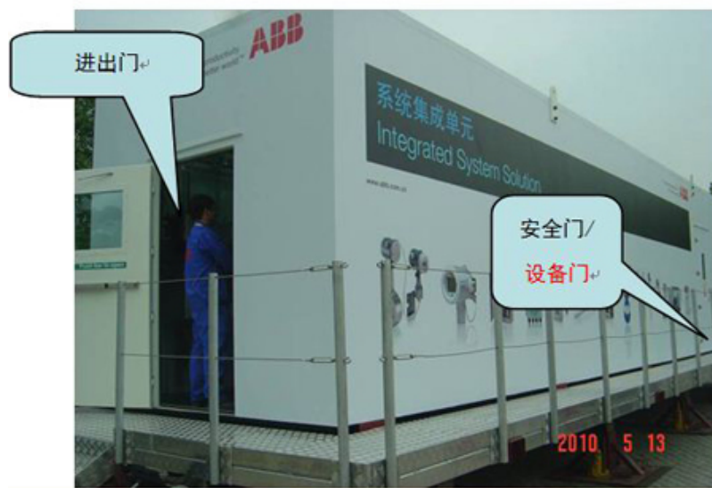
图10 集装箱式的自动化小屋外貌
